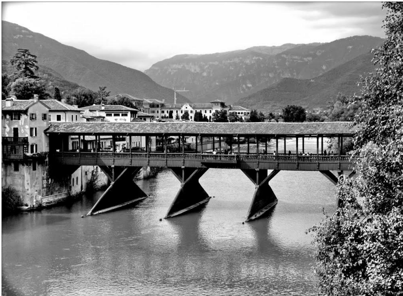
Figure 1: Ponte degli Alpini in Bassano del Grappa, IT.
